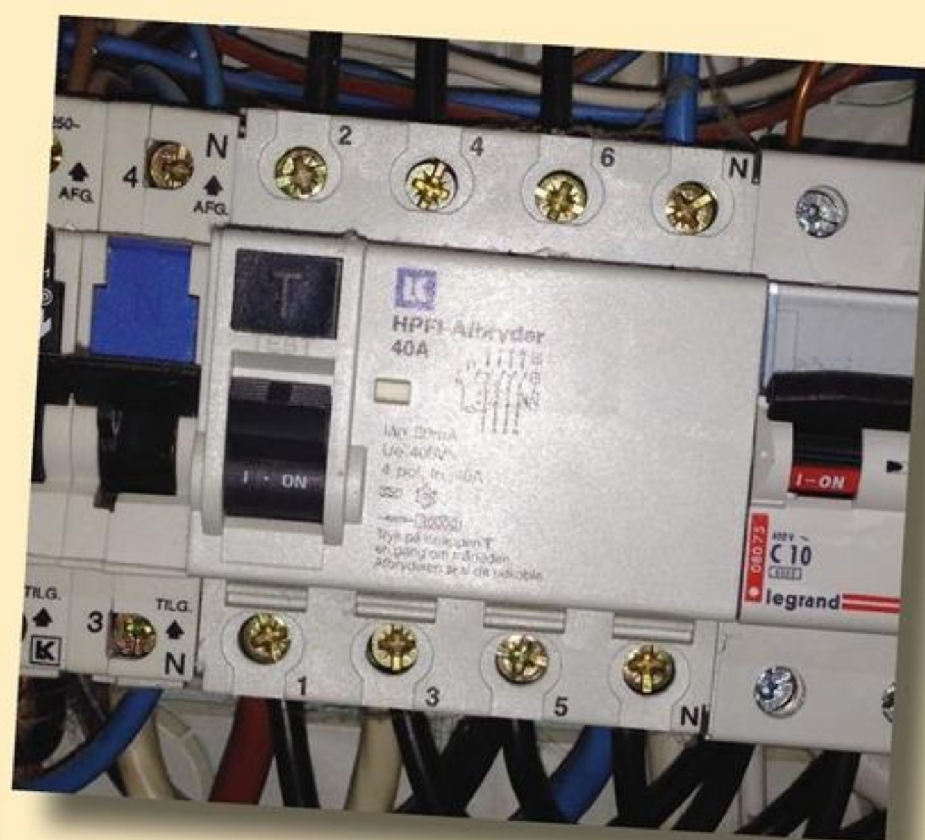
Fig. 23. Forkert type fejlstrømsafbryder.
