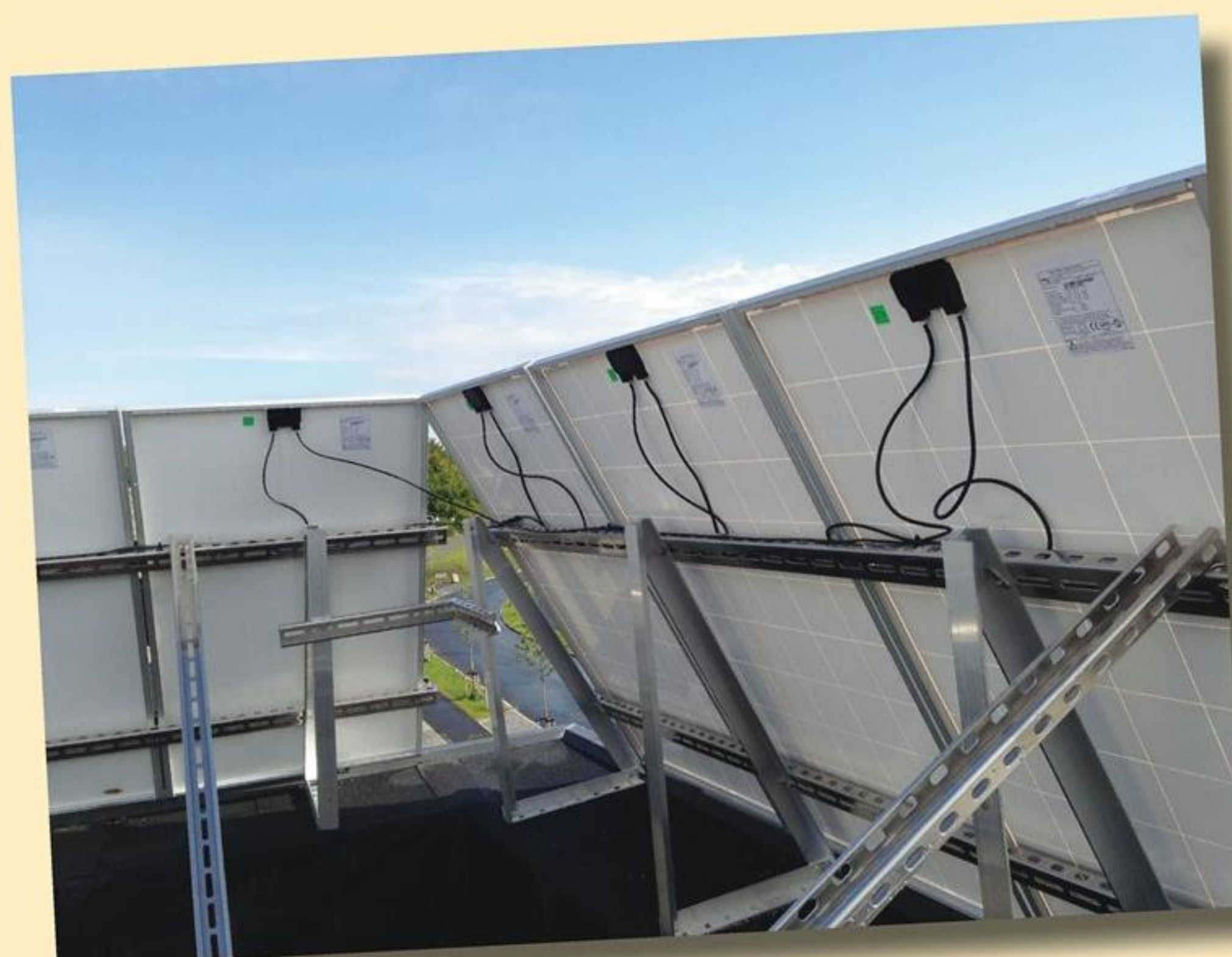
Fig. 11. Forskellig orientering af solceller i samme streng.
