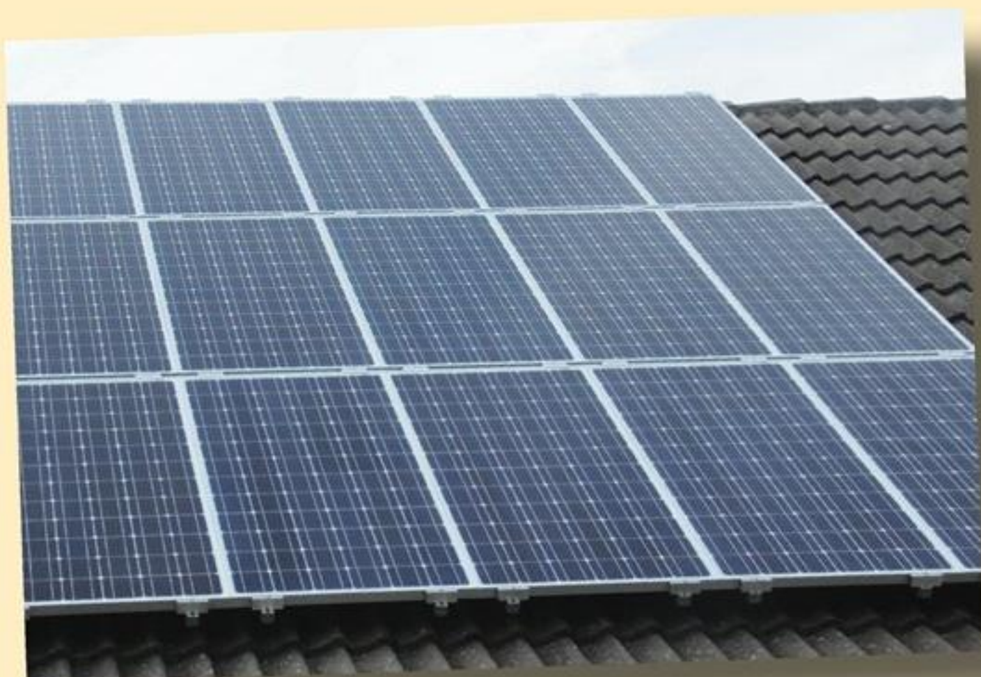
Fig. 17. For lille afstand mellem solcellepaneler.
