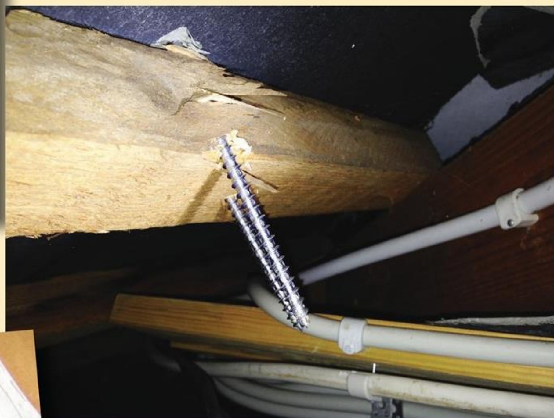
Fig. 20. Ansatsskrue ureglementeret monteret, lægte flækket.
