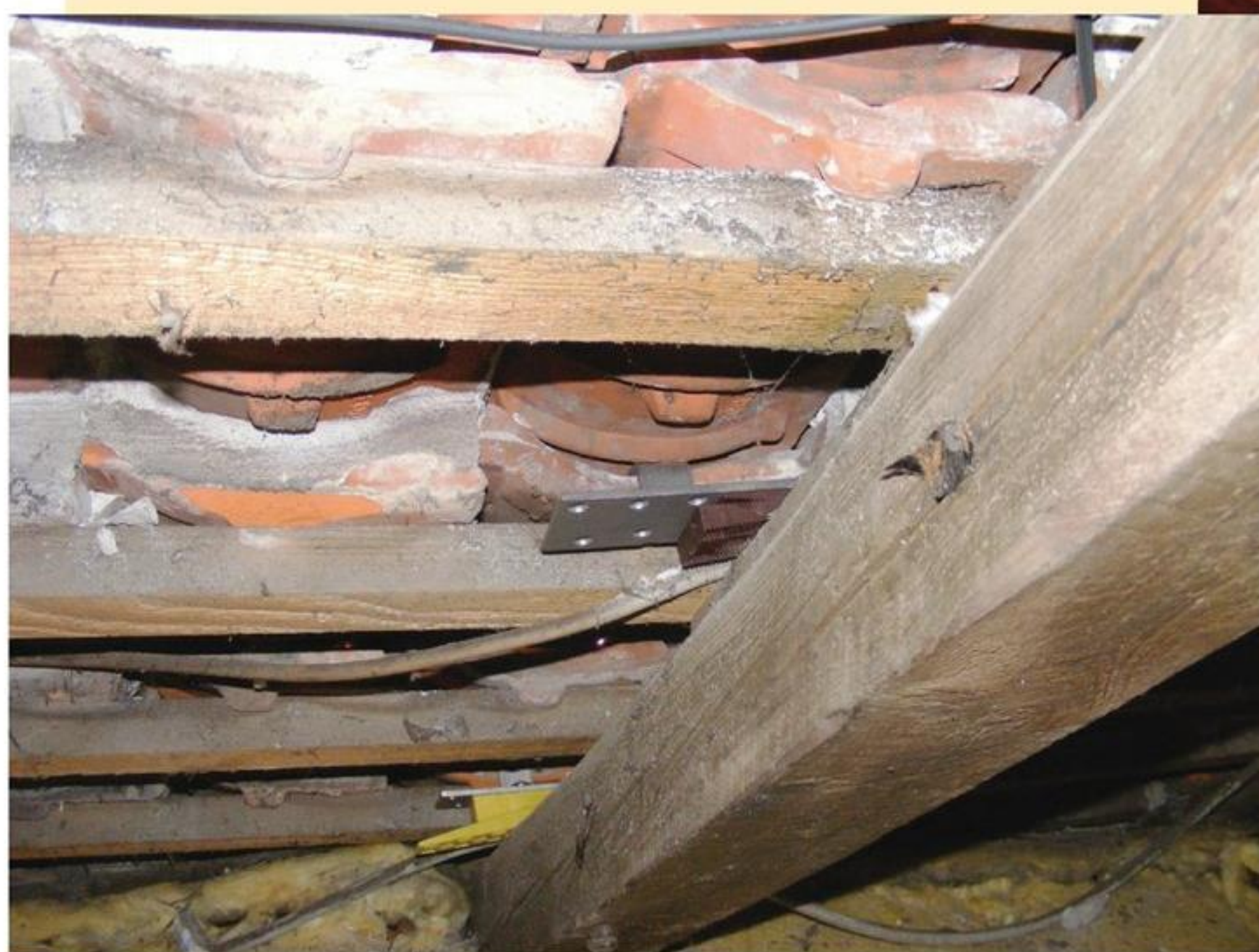
Fig. 19. Understrygning krakleret.
